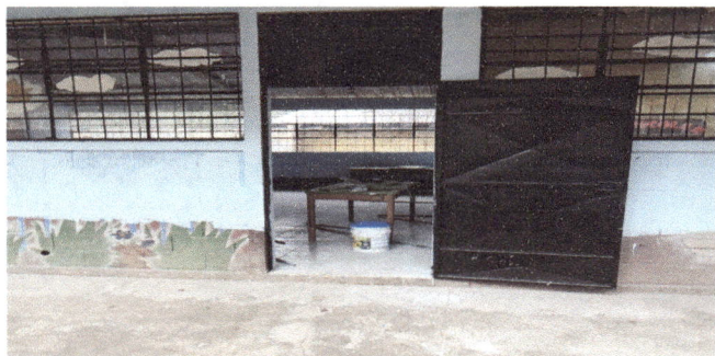
Foto 9: se le da mantenimiento a las paredes de las aulas pintandolas por dentro y por fuera.
