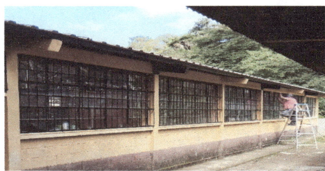
Foto 4: Se procede al cambio de algunos vidrios quebrados de las ventanas de 3 aulas y la dirección, y se realiza la instalación de valcones
