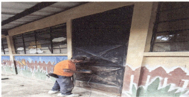
Foto 3: se le da mantenimiento a 5 puertas de metal
