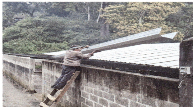
Foto 8: fabricacion e instalacion de canales para bajada de agua frente a las aulas
