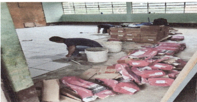
Foto 5: se procede a la instalación de piso cerámico en 3 aulas y la dirección
