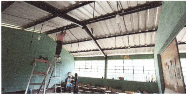
Foto 1: Se realiza el cambio del sistema eléctrico de 3 aulas y la dirección
